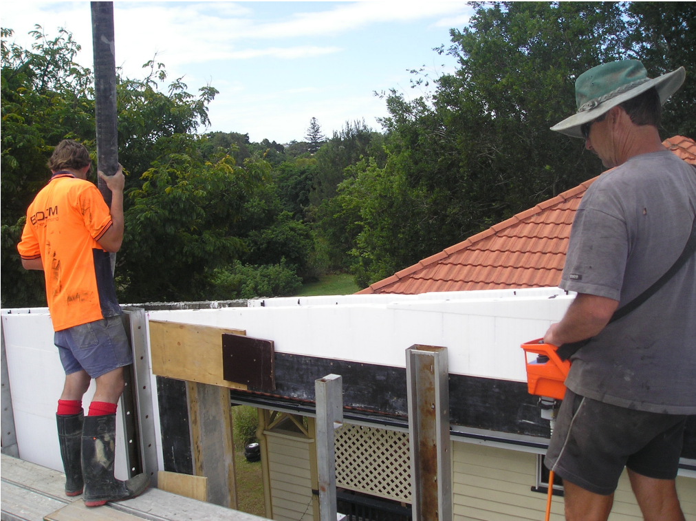
Photo: Concrete pour with a boom pump.
